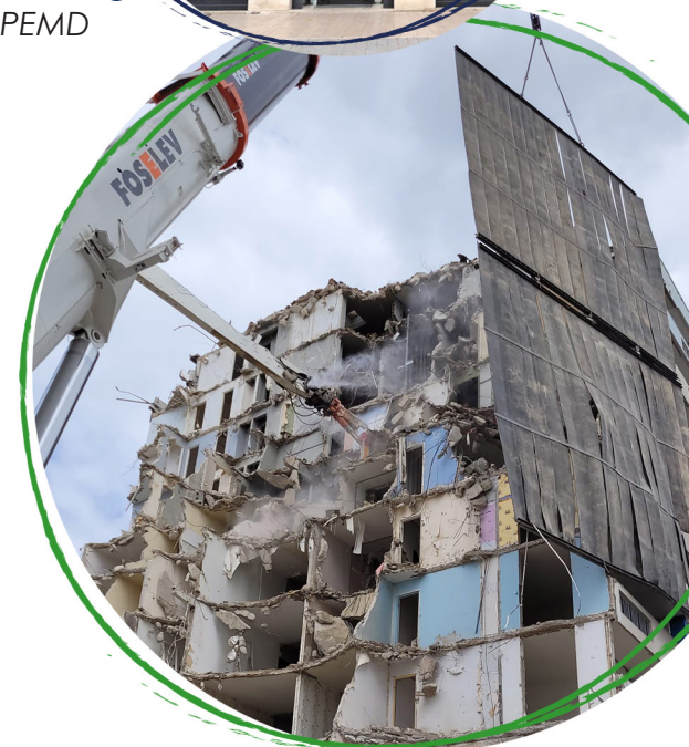
CLAMART Démolition de 351 logements
